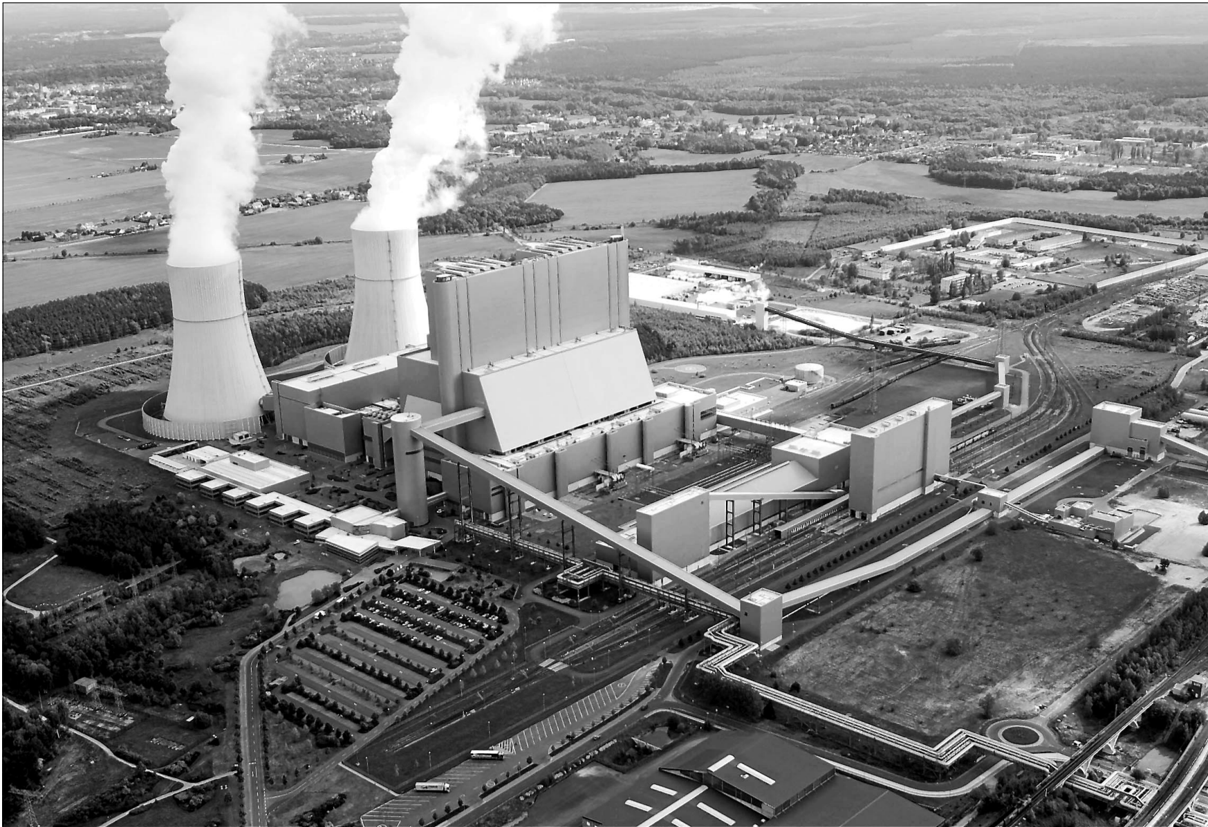
Am Montag beginnt auf dieser Freifläche vor dem Braunkohlekraftwerk Schwarze Pumpe der Bau einer weltweit einzigartigen Forschungsanlage. Vattenfall errichtet dort für rund 50 Millionen Euro bis 2008 das erste CO 2 -freie Braunkohlekraftwerk. Die Pilotanlage mit einer thermischen Leistung von 30 Megawatt dient der Forschung und Entwicklung einer neuen Technologie, dem Oxyfuel-Verfahren. Dabei soll das während der Braunkohleverstromung anfallende Kohlendioxid abgeschieden und danach dauerhaft gespeichert werden. Foto: Rainer Weisflog
