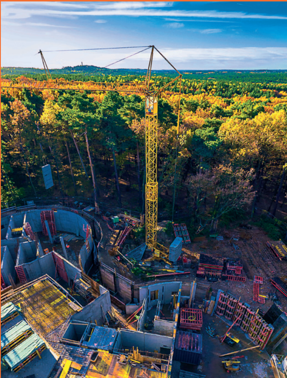
Baustelle des PIK-Neubaus auf dem Telegraphenberg. Foto: Lothar Lindenhan
