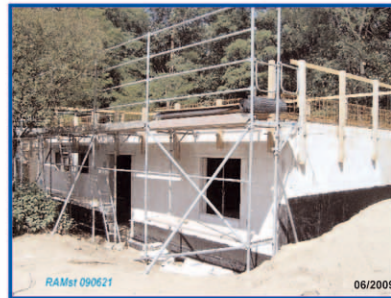
Oben: Rohbau des neuen Laborgebäudes der "RAMst"
