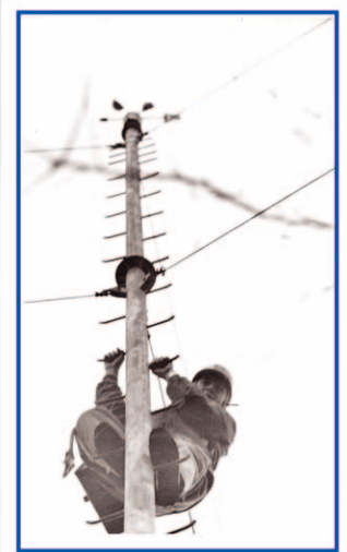
Rechts: Wartung des Windmessgerätes auf dem großen Turm 1975
